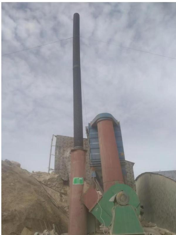
图 3-1 除尘器+15m 排气筒
